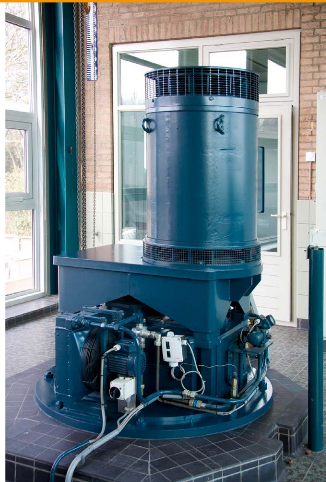
Motor van de Pompinstallatie
